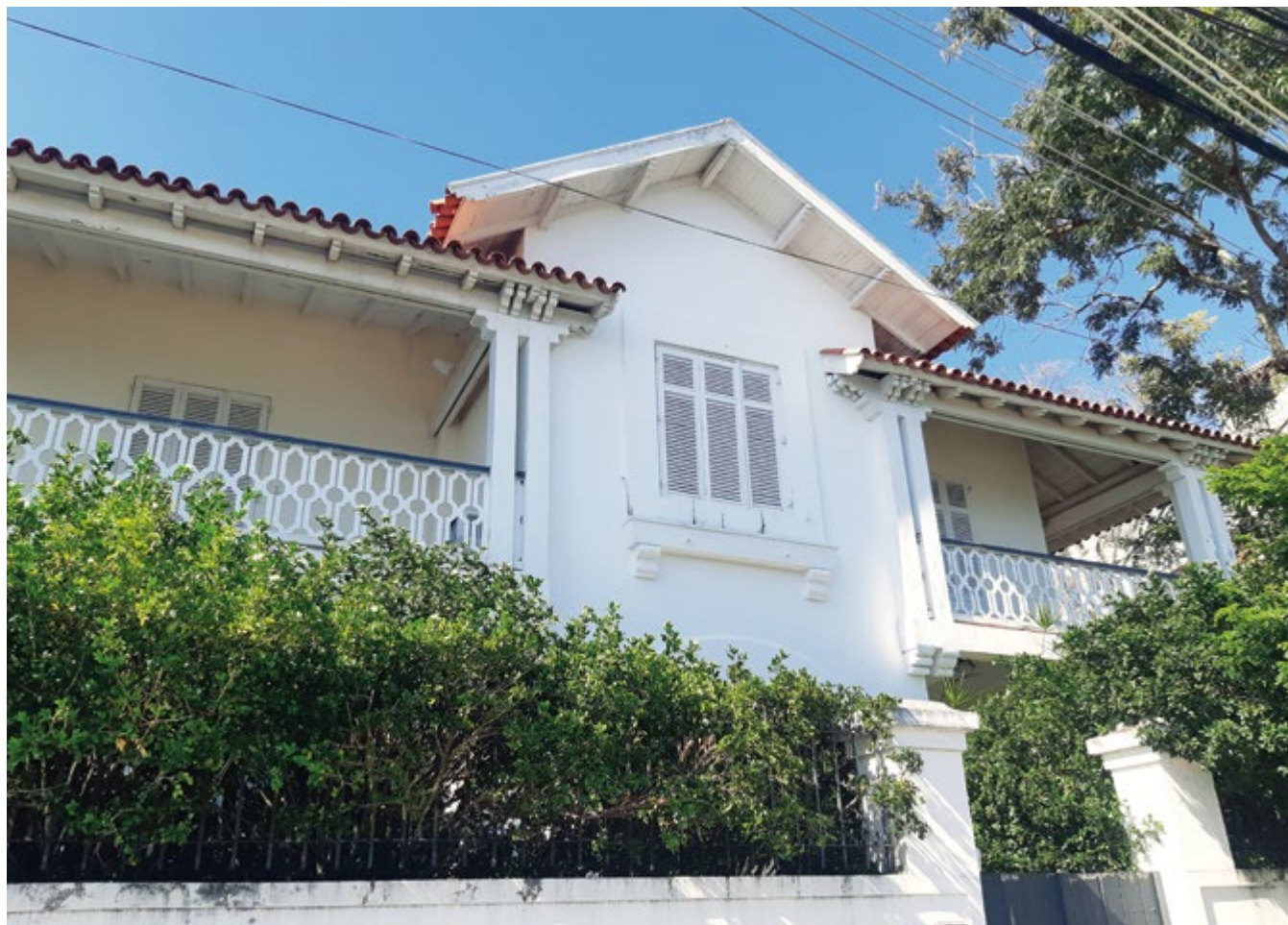
Uso de beirais e telhados com movimento. Detalhe de varanda com guarda-corpo bem trabalhado em madeira. Fotografia Eduardo Ribas
